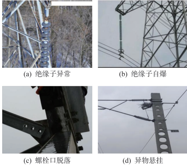
图 2 输电线路故障检测数据集示例
